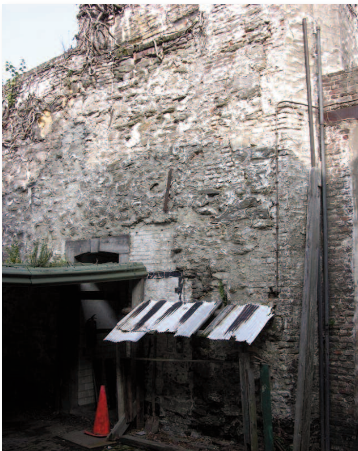
41. Daarbij zijn oude stenen hergebruikt in een slordig metsel verband. Wel zijn aan de binnenplaats hardstenen kozijnen gebruikt.
