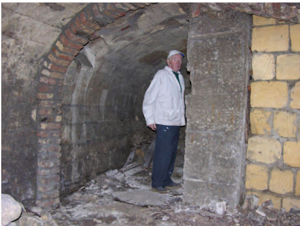
21. Fraai zijn de diverse steunconstructies te zien. De man in beeld is Pie Kerpentier, die met zijn 72 jaar al 60 jaar in dienst is van Bauduin, en een gewaardeerd zegsman ter plekke was.
