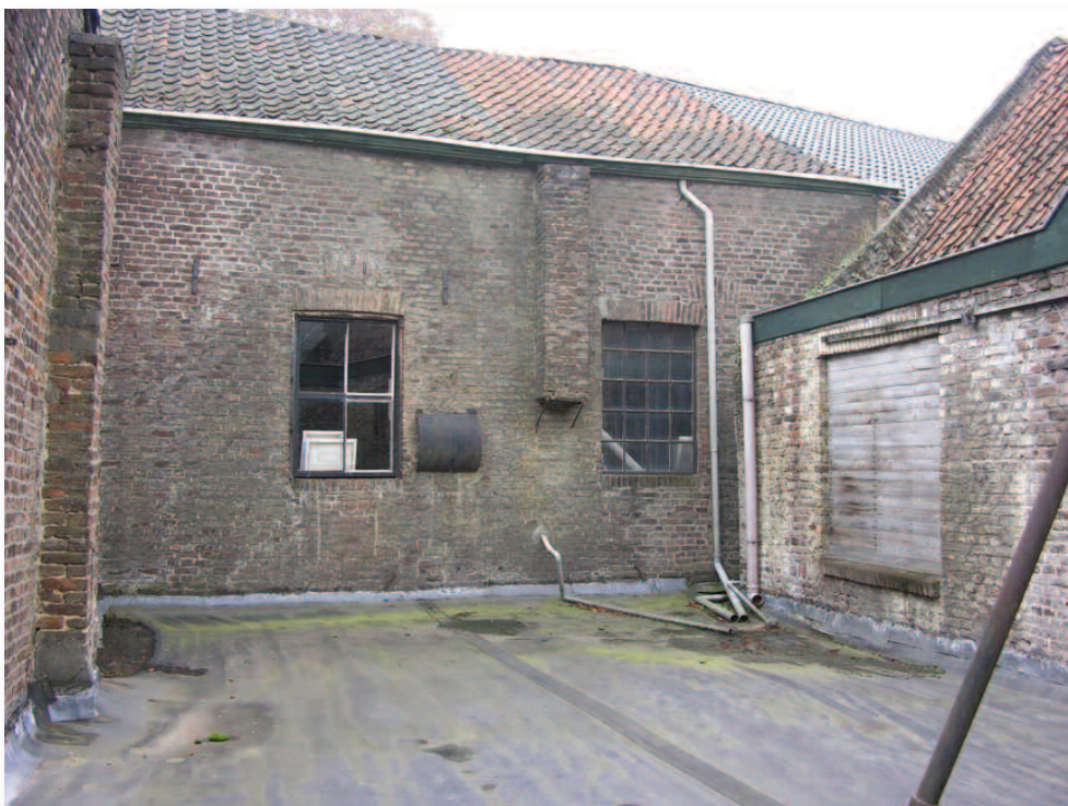
29. Het platte dak van bouwdeel 10 met rechts de achterkant van deel 12 en recht vooruit deel 11. De daken zijn deels nog gedekt met oud-hollandse pannen.
