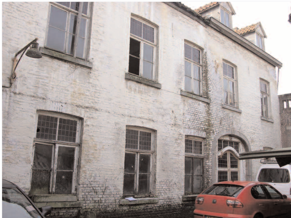
44. De voorgevel van het woonhuis. Aan de onderbreking van de dakgoot is de scheiding af te lezen van de samenstellen de bouwdelen. Het rechter deel is 18de eeuws, maar met 17de eeuwse restanten.
