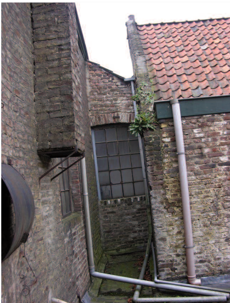
29. Het platte dak van bouwdeel 10 met rechts de achterkant van deel 12 en recht vooruit deel 11. De daken zijn deels nog gedekt met oud-hollandse pannen.
