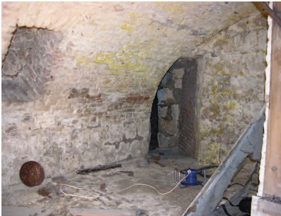
35. Aan de zuidkant is in de hoek van deze kelder een doorgang gemaakt naar de kelder onder bouwdeel 4. Rechts gaat de trap naar buiten.
