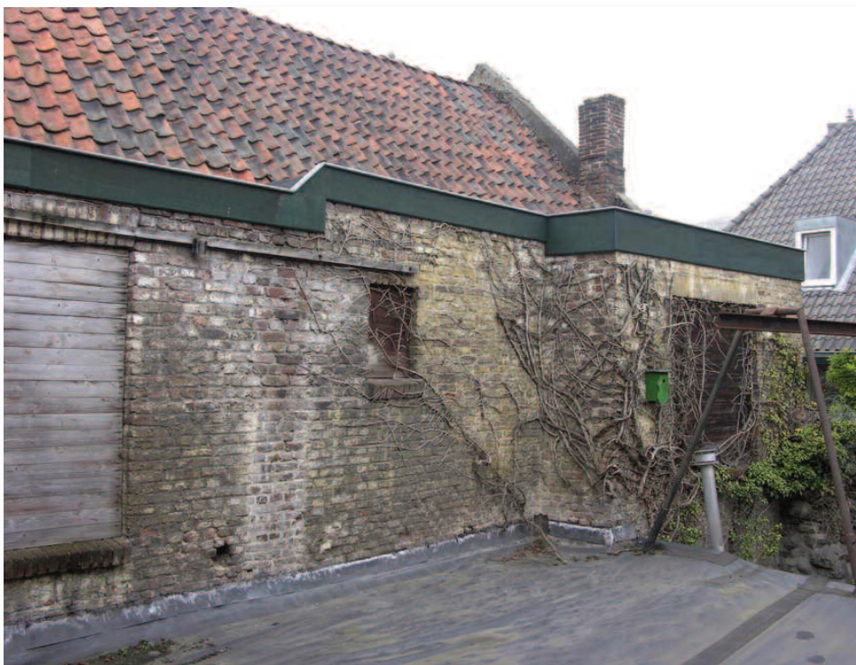
37. Aan de achterzijde, vanaf deel 10, zijn de uitbreiding en ophoging eveneens te zien.
