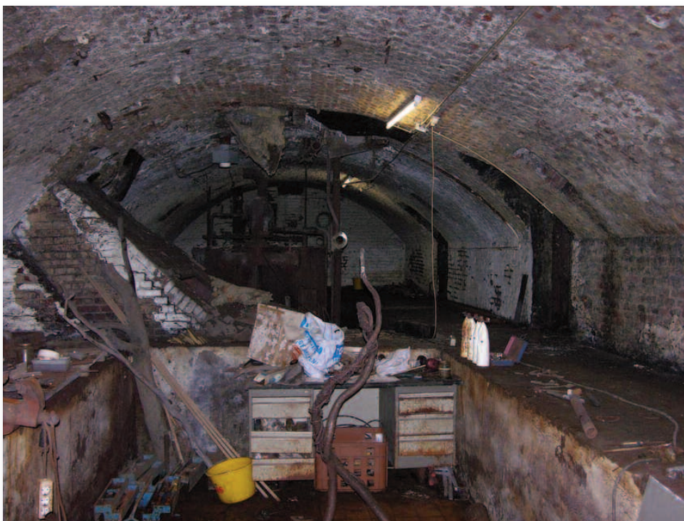
70. De kelder ernaast is 19de eeuws en hoort mogelijk bij de herbouw van de molen. In de verdiepte vloer stonden de verwarmingsketels van de fabriek, waar ook de hitte geleverd werd om de graanproducten mee te drogen. Halverwege gaat een gesleepte schoorsteen naar de op het terrein staande tweede schoorsteen, bouwdeel 24.
