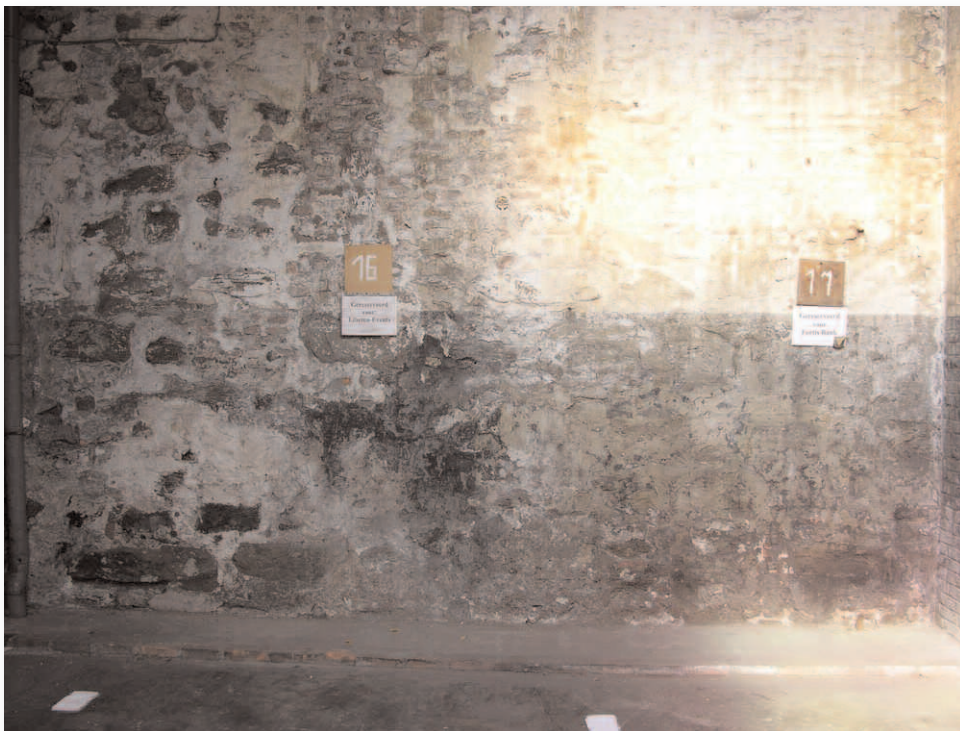
62: Detail van de muur in breuksteenmetselwerk
