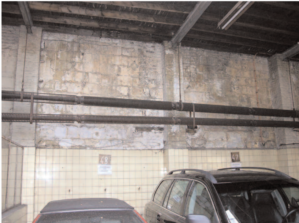
52. In de garage zijn, aan de zuidkant, muurfragmenten bewaard van een gebouw dat verder helemaal verdwenen is, maar deel uitmaakte van het veel grotere complex van de meekrapmolen, die op zijn beurt ook weer was samengesteld uit tal van bouwdelen. De muur staat op de grens tussen vermicellifabriek en garage.
