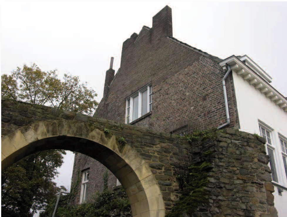
55. De noordelijke topgevel is op de stadsmuur opgetrokken met gebruikmaking van de stenen van de gesloopte voorganger. De top is na een granaatinslag in 1941 opnieuw opgetrokken.
