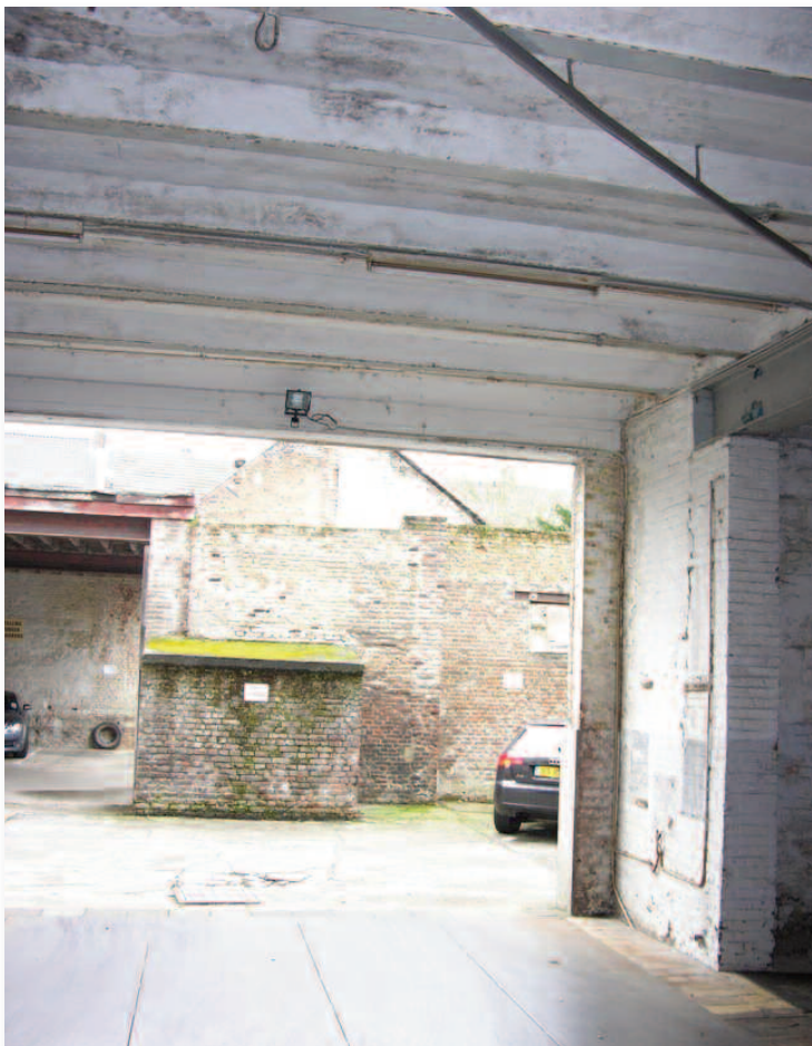
74. Staande in bouwdeel 17, met de rug naar het woonhuis (16) is te zien dat die naad correspondeert met een muur ter plekke. Die muur liep inderdaad door als onderdeel van een van de gebouwen van de meekrapmolen.
