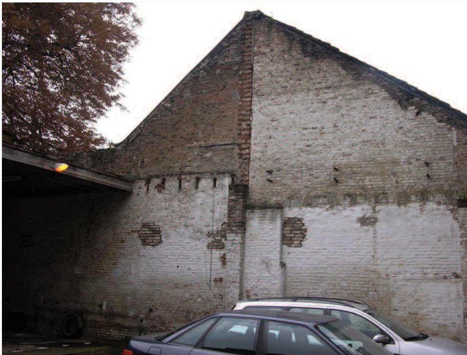
73. Aan de zuidkant van de kelders geeft een open plek aan waar tot een jaar of 20 geleden nog een overkapt stuk stond van een gebouw dat aanvankelijk doorliep in het nog bestaande
