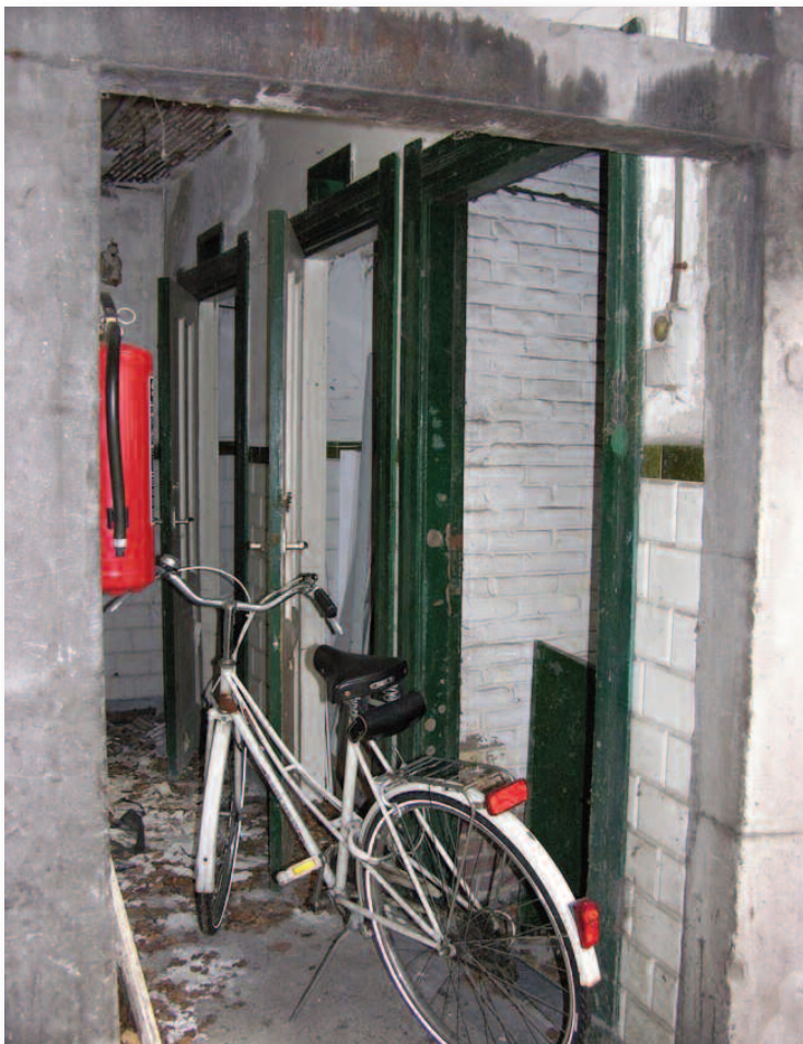
42. Het bouwdeel, 14, is in 1925 veranderd tot toiletruimte voor de garagearbeiders.
