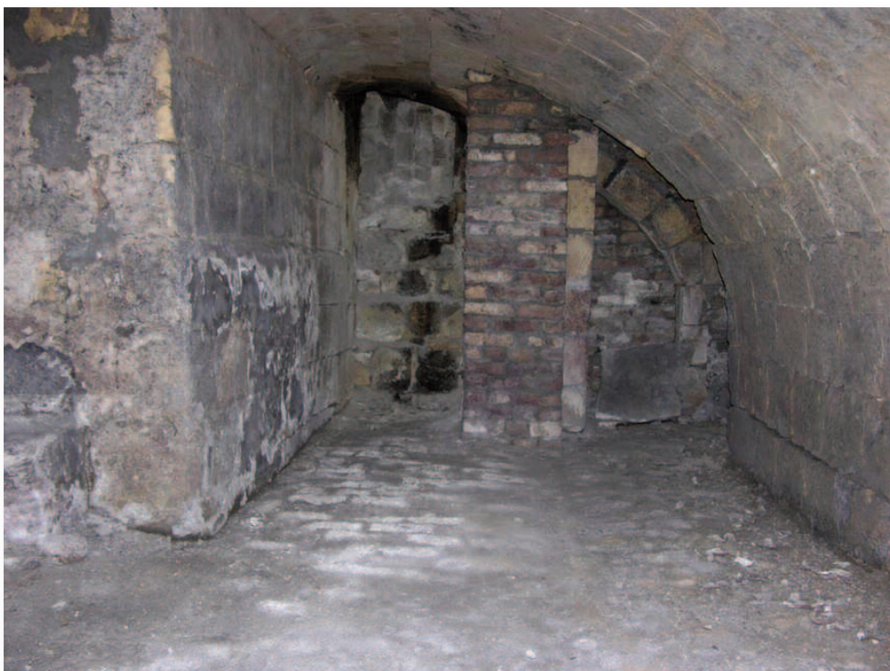
17. De kelder naar achter gezien met sporen van grotendeels verdwenen kelders en een doorgang naar een nevenkelder.
