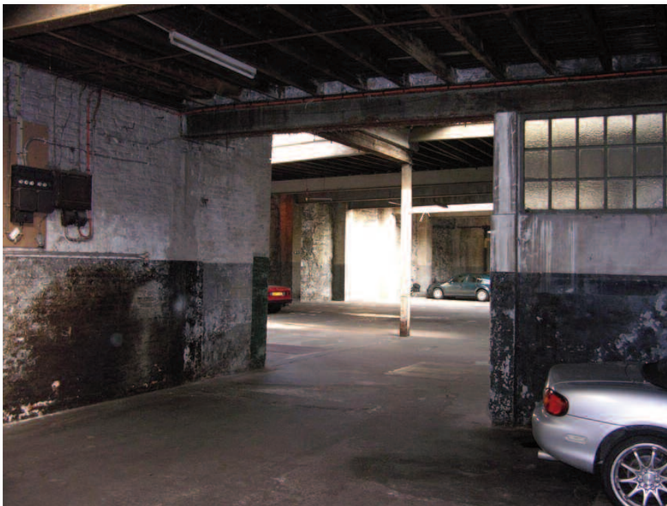
58. De garage vanuit bouwdeel 21 richting de stadsmuur gezien.
