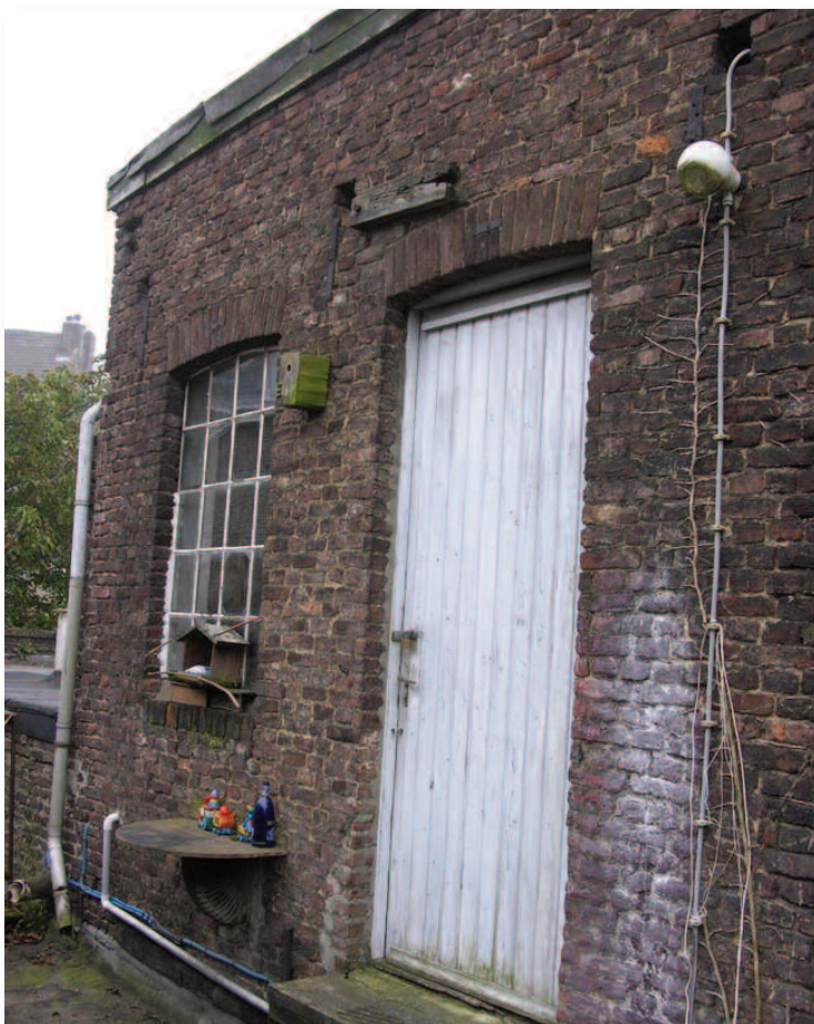
25. Rond 1920 is het gebouw opgehoogd en van een plat dak voorzien, waarbij ook nieuwe ramen en deuren zijn aangebracht. Vele malen ingrijpend verbouwd.
