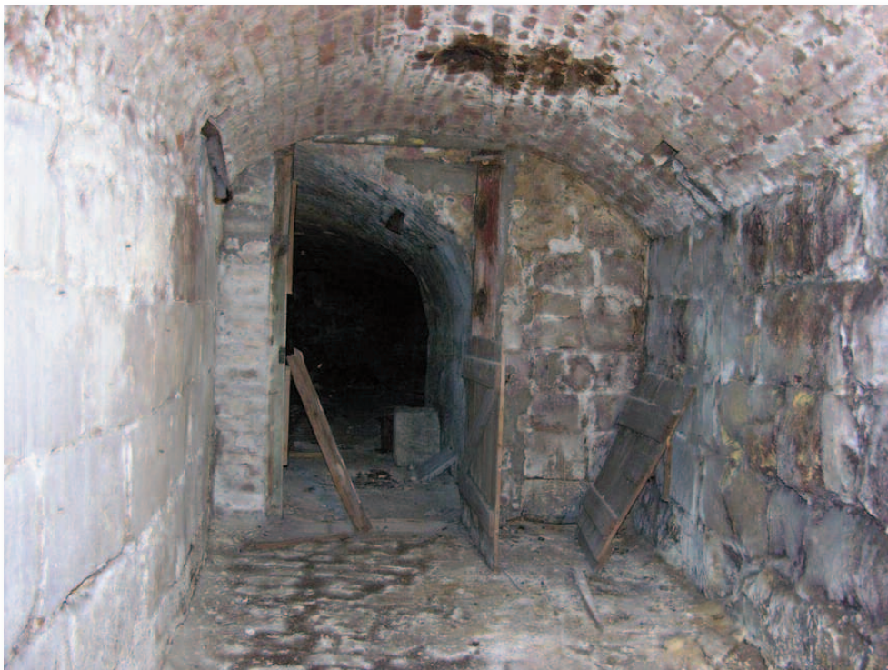
9. De kelder van het naastgelegen bouwdeel 4, naar het zuiden gezien. Het gaat om een verbinding van de kelder onder bouwdeel 11, waar de entree zit, naar de eigenlijke kelder.
