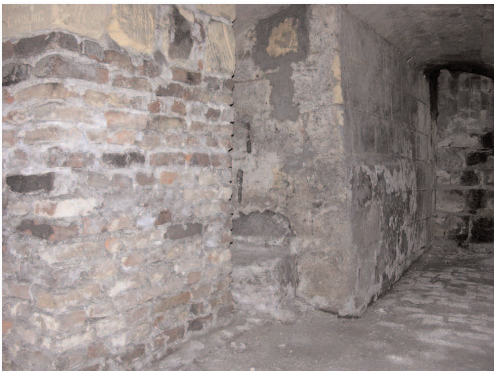
18. Links zijn enkele blokken gemetseld ter ondersteuning van machines in de vroegere fabriek.
