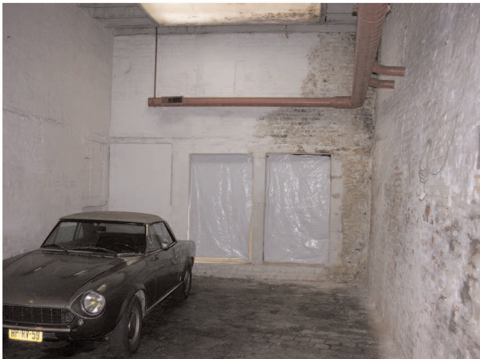
12. De voorgevel van het achterhuis van Grote Looiersstraat 18, van binnen gezien. Het achterhuis bestaat niet meer maar maakt deel uit van de fabriek. De ramen kijken nog uit op de tuin.
