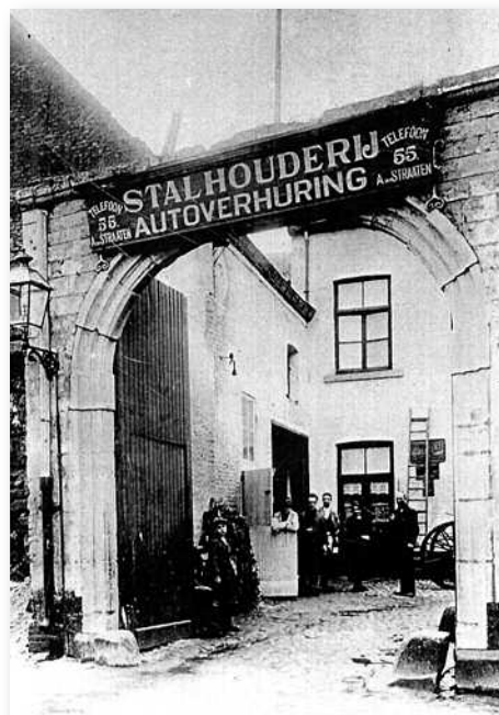
Looiersgracht ter plekke van huidige nummer 1 a/b: de beide poorten voor de sloop t.b.v. bouw garage Michon
