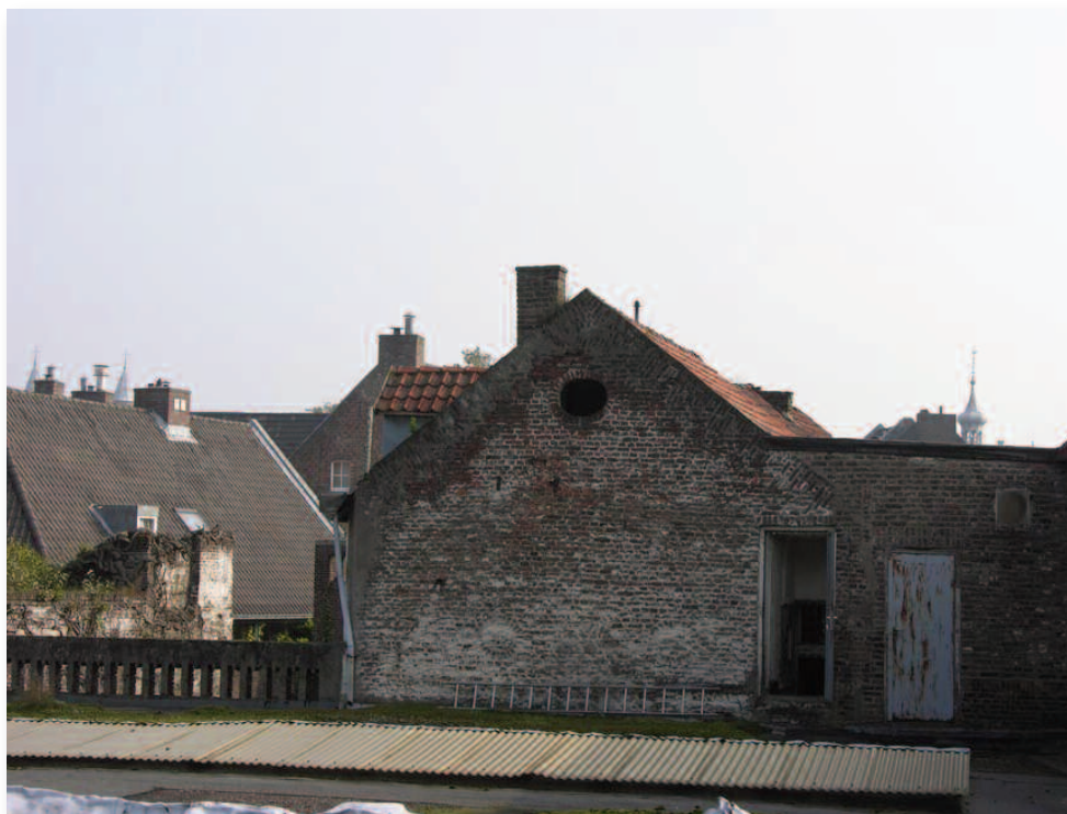
47. In de westelijke topgevel van het woonhuis zijn een aantal ovale openingen te zien die horen bij het laat-17de eeuwse huis.
