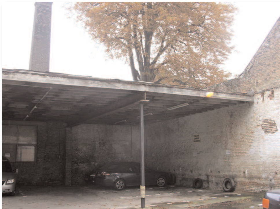
76. Tussen de voormalige paardenstal en de schoorsteen ligt een ander fragment ouder muurwerk, onderdeel van een met een plat dak gedekt bouwdeel dat eveneens pas na 1947 bij de fabriek getrokken werd. Aan de noordkant ervan lag tot rond 1950 een bouwdeel met een onderdoorgang naar het westelijke stuk van het fabrieksterrein.
