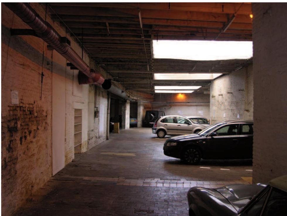
13. De fabriek uit 1915, te beginnen met bouwdeel 5. Links deel 4. De ruimte loopt tot de trafo achter de stadsmuur.
