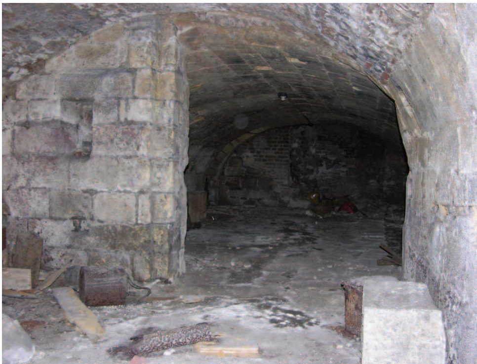
10. De kelder onder bouwdeel 4, met op het einde een trap naar boven.
