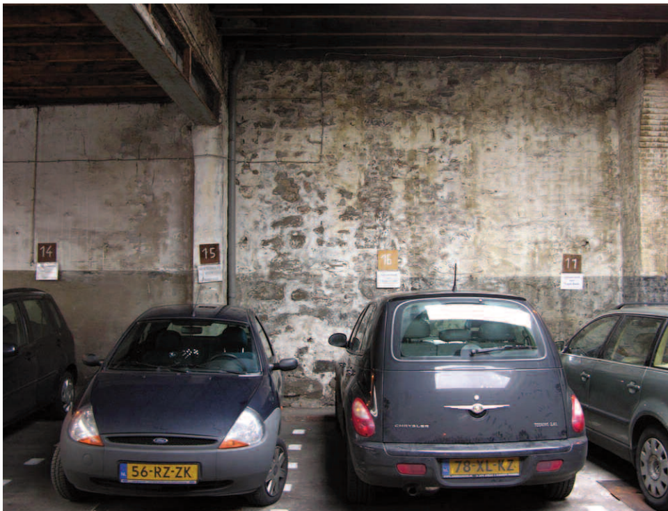
61. De stadsmuur is in de vroegere garage Van Straaten over 7 vakken, ontstaan door de kolommen voor het dak, te zien. In de garage Michon is de muur weggestuct.
