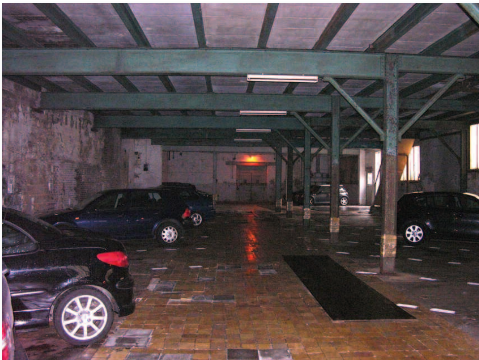
66. De fabrieksruimte uit 1931, bouwdeel 23, naar de westkant gezien.
