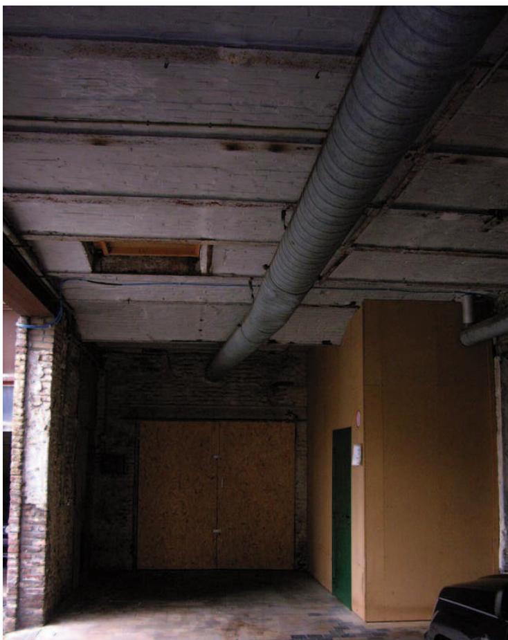
33. De ruimte van bouwdeel 11 inpandig, op de begane grond, naar het noorden gezien. Het plafond bestaat uit ijzeren ribben met een betonnen dek, dat rond 1920 is gelegd.
