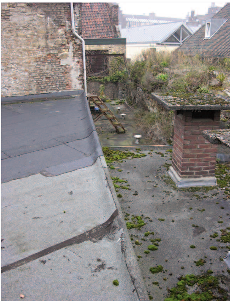
26. De ruimte tussen bouwdeel 7 in de stadsmuur, met op de voorgrond de trafo.
