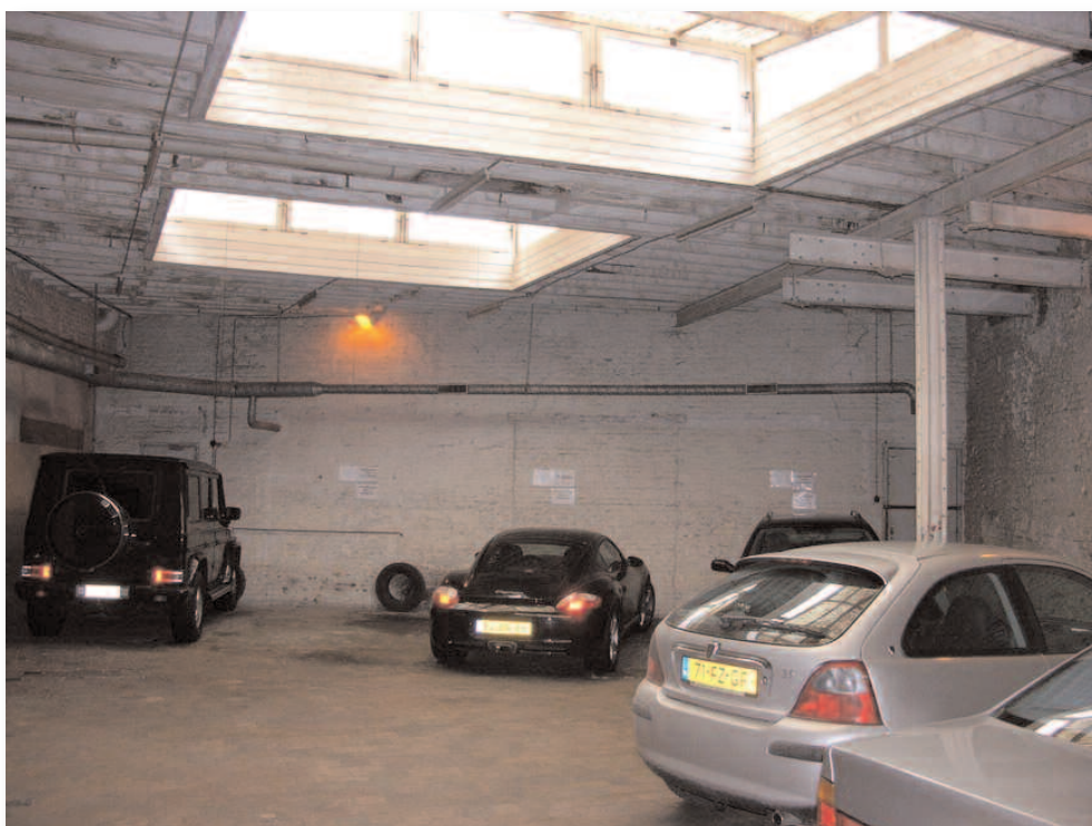
15. Ruimte 5 aan de noordkant, ter plekke van verdwenen gebouwen, waarvan wel nog kelders bestaan.
