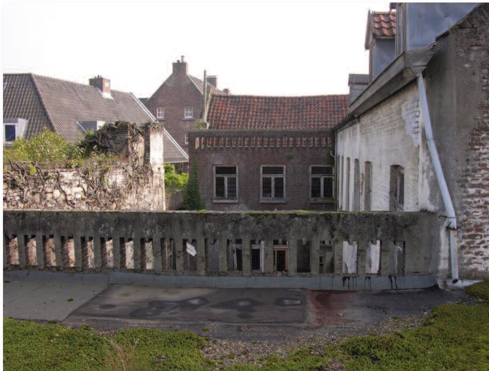
43. Zicht op de open plaats bij het woonhuis van Van Straaten, bouwdeel 16, vanaf het dak van de garage. Aan de overkant staat de zijvleugel van het woonhuis, rechts de woning. Bouwdeel 14 ligt links.
